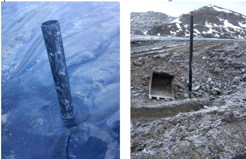
Figur 22 Foderrör till portryckmätare
