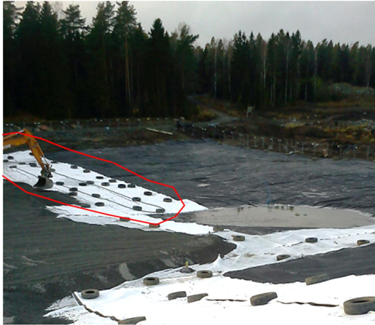
Figur 24 Slang för sättningsmätning på geomembranet
